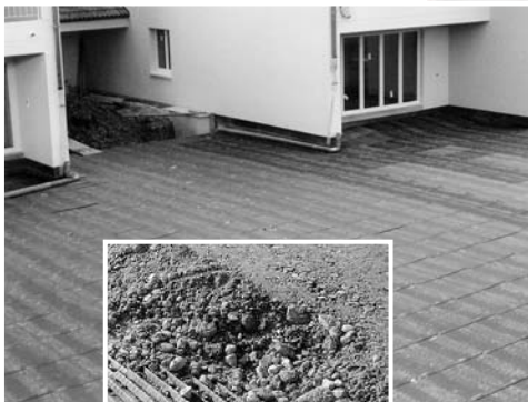
REPLAST «R» horizontal verlegt als Schutz- und Entwässerungsschicht
