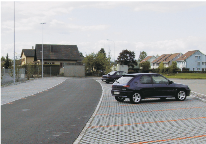
Remplissage avec du verre pilé
